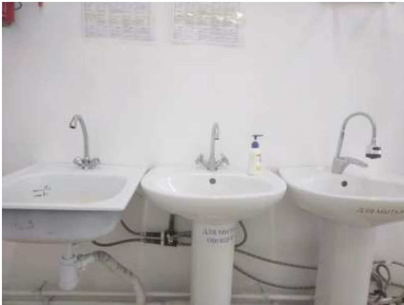
установили 2 доп. раковины в горячем цеху
